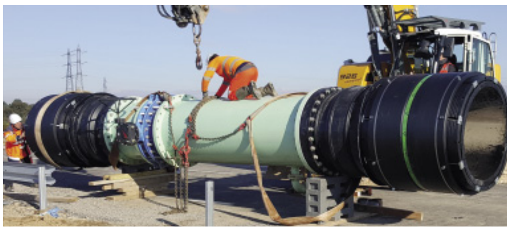
Bild 2: Alles vorbereitet: Zweimal FRIALEN XL Keilmuffe als „Überschieber“ kurz vor der Einbindung.
