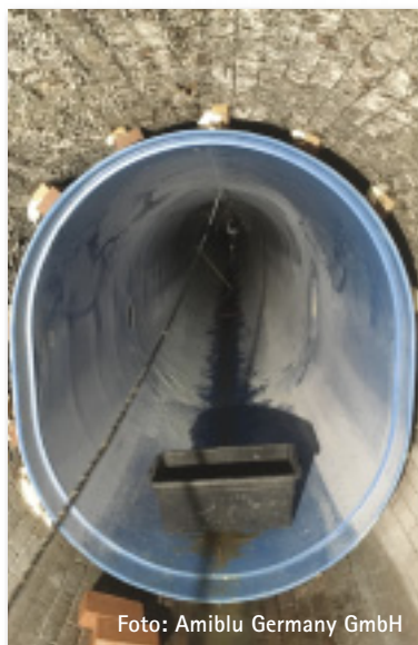
Bild 5: Die Rohrprofile sind optimal an das alte Profil angepasst; der Ringraum wird später fachgerecht mit Dämmverfüllt.
