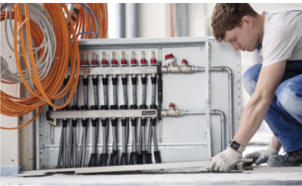
Bild 6: Der Anschluss an den Heizkreisverteiler vom Typ Logo erfolgt einfach über Steckverbindungen per Hand.
