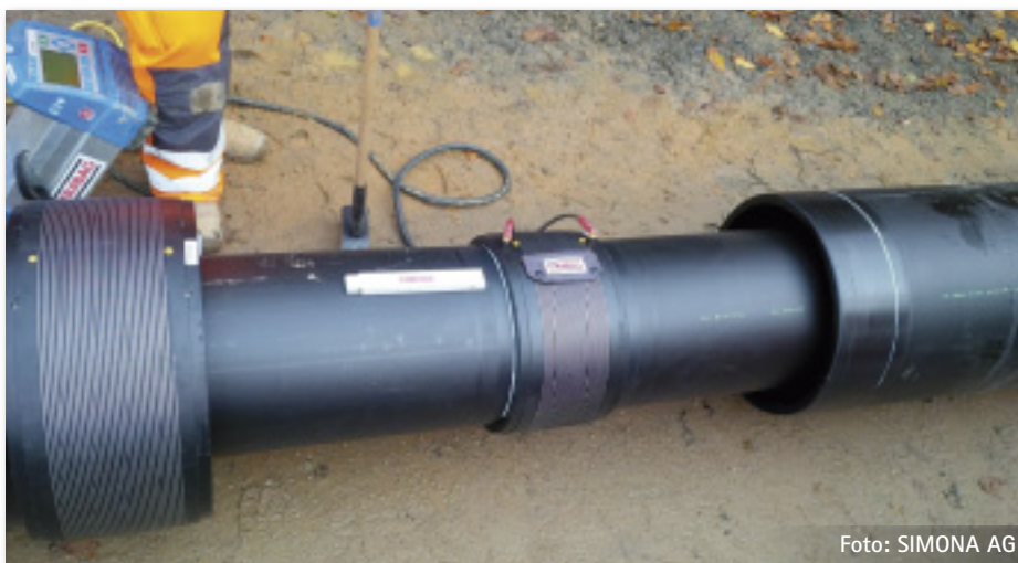
Bild 4: Verschweißen der Rohre mit dem Kaskadenschweißverfahren
