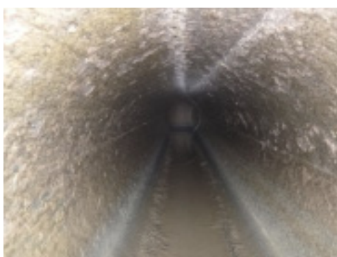
Bilder 8 und 9: Blick in das schadhafte Asbestzementrohr / neue PE-Rohr Compact Pipe®
