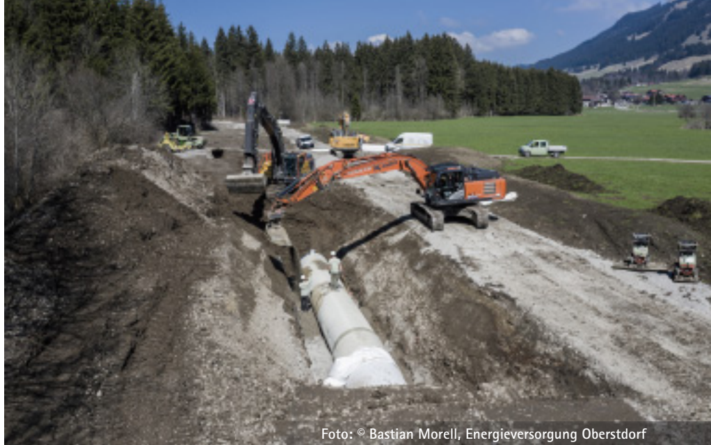
Bild 2: In relativ geringer Tiefenlage wurden die GFK-Rohre in offener Bauweise auf der gesamten Strecke von 2,35 km verlegt.
