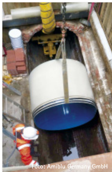
Bild 4: Der Einbau erfolgte mithilfe eines bemannten Rohrshuttle.
