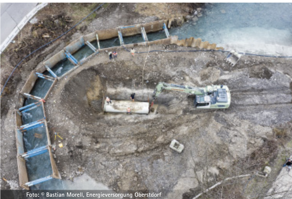
Bild 3: Der aus Kanalverbauerelementen und Spundwänden hergestellte Bypass leitet das Wasser der Trettach an der Dükerbaustelle vorbei. So konnten auch hier die Rohre in offener Bauweise im trockenen Flussbett verlegt werden.
