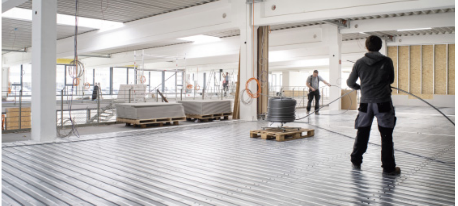
Bild 2: Das extra weiche TECEfloor Aluminium-Verbundrohr liegt formstabil auf dem Abroller und die Verlegung erfolgt weitgehend drallfrei.
