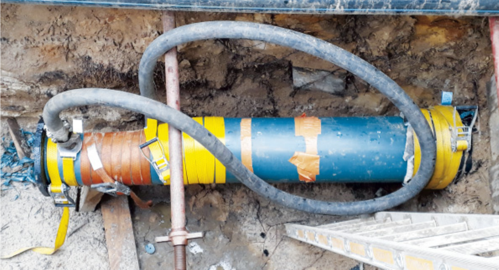
Bild 4: Compact Pipe® im Baugrubenbereich während der Rückverformung.
