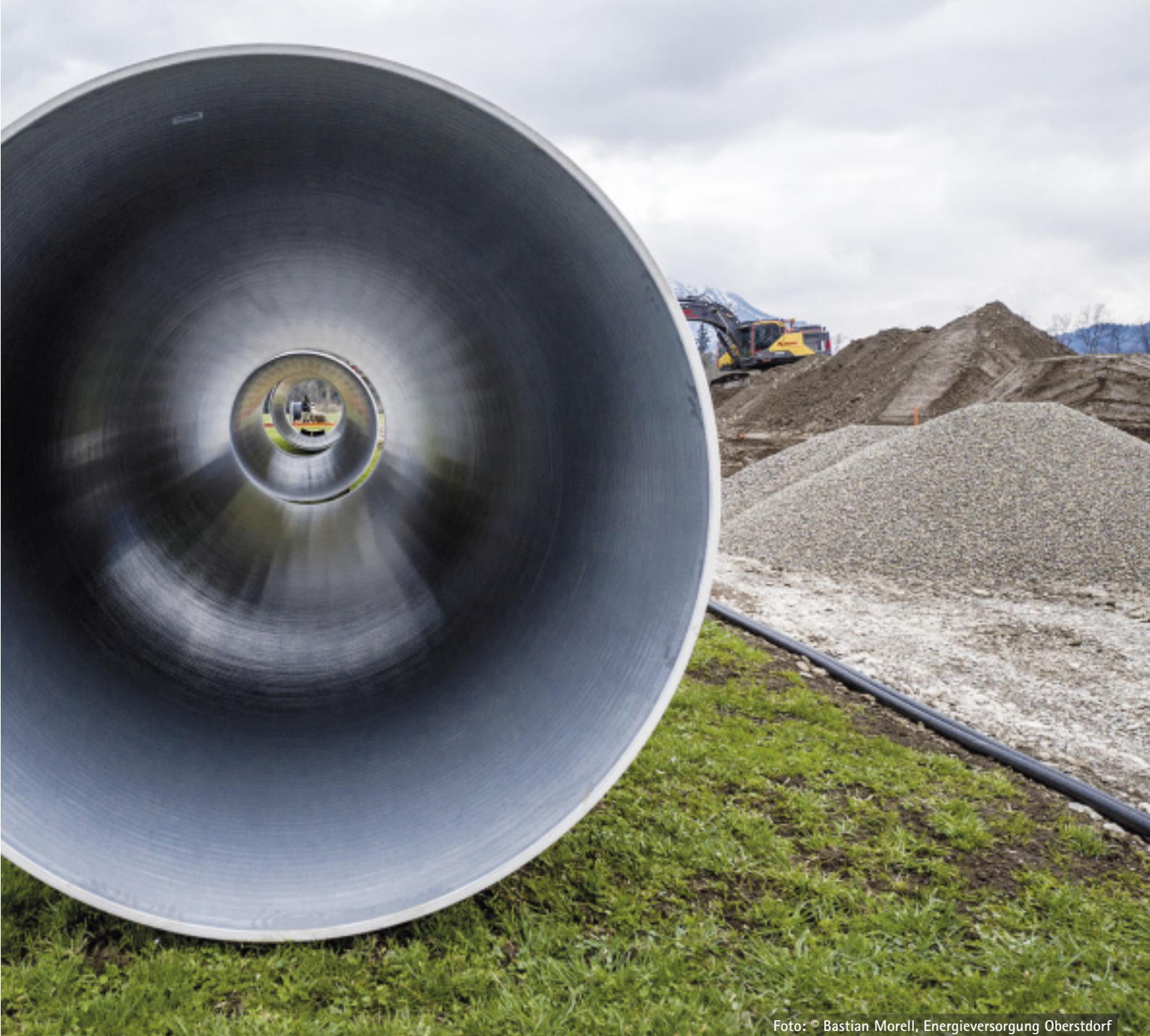
Bild 1: Die Flowite Grey Rohre DN 1800 mit einer Länge von je 12 m wurden neben der Leitungstrasse bis zum Einbau gelagert.
