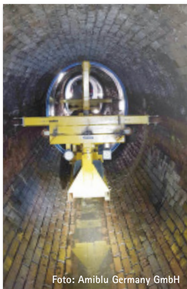
Bild 4: Der Einbau erfolgte mithilfe eines bemannten Rohrshuttle.
