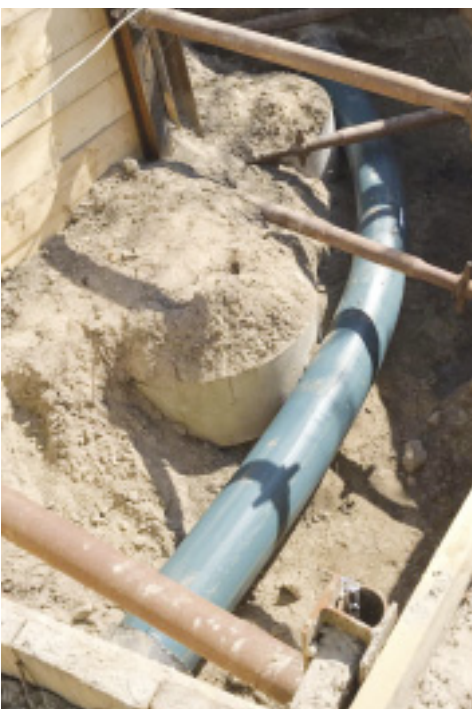
Bilder 5, 6 und 7: Zwangspunkt mit Richtungsänderung ca. 45 Grad nach Installation/Molchschleuse/Compact Pipe/Friafit® Bauteilanbindungen auf Compact Pipe®.
