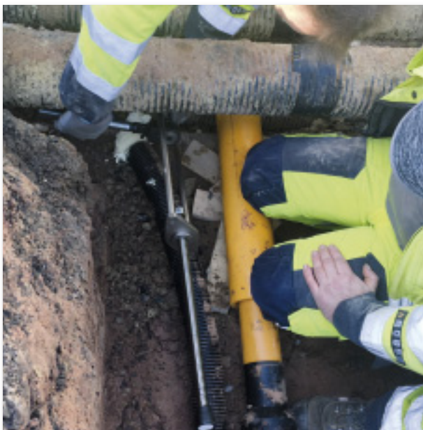
Bild 3a und 3b: Trotz enger Platzver- hältnisse kann der Abzweig problemlos erstellt werden
