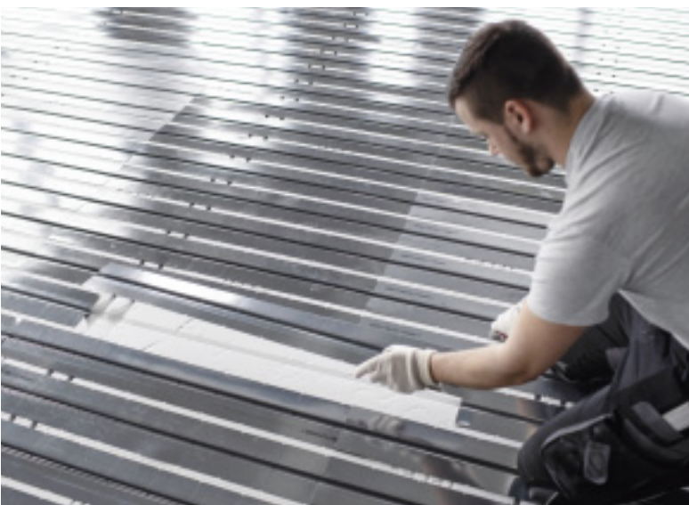
Bild 3: Die Heizungsrohre werden innerhalb der Dämmschicht aus expandiertem Polystrol verlegt. Die Wärmeleitbleche aus verzinktem Stahl sorgen für eine gleichmäßige Verteilung und Abgabe der Wärme.
