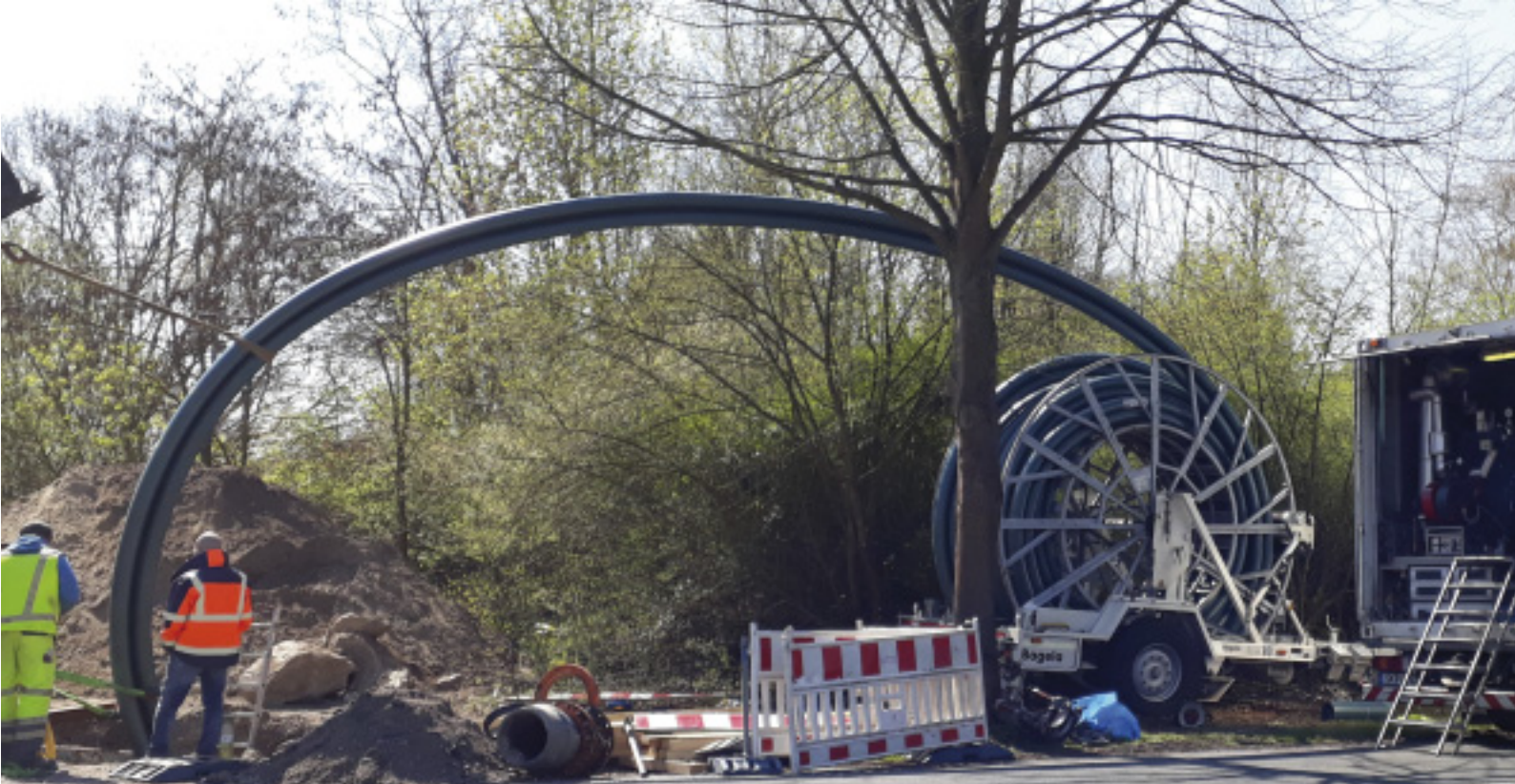
Bild 1: Einzug im freien Biegeradius mit einem Bagela Trommelanhänger.
