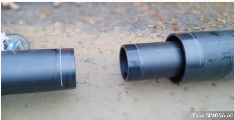
Bild 3: Vorbereitung zum Verschweißen des Innenrohres: Das Innenrohr muss zum Verschweißen aus dem Außenrohr herausstehen
