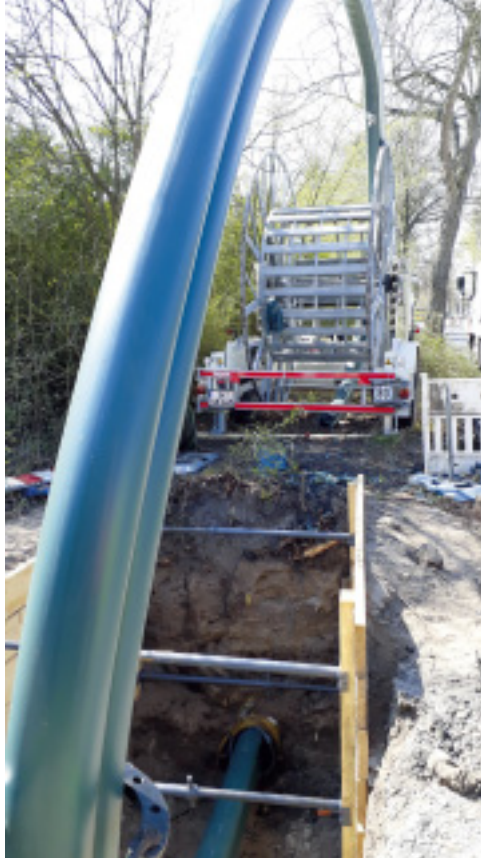
Bilder 2 und 3: Die Anlieferung des Compact Pipe: Werkseitig C-förmig vorverformt.
