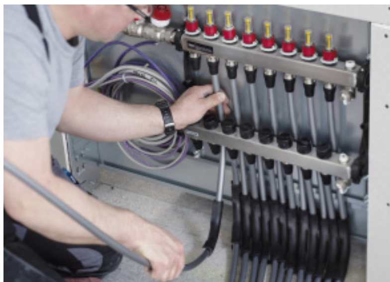
Bild 6: Der Anschluss an den Heizkreisverteiler vom Typ Logo erfolgt einfach über Steckverbindungen per Hand.
