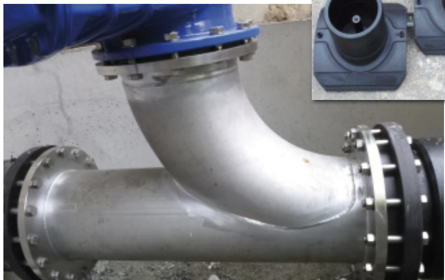
Bilder 5, 6 und 7: Zwangspunkt mit Richtungsänderung ca. 45 Grad nach Installation/Molchschleuse/Compact Pipe/Friafit® Bauteilanbindungen auf Compact Pipe®.
