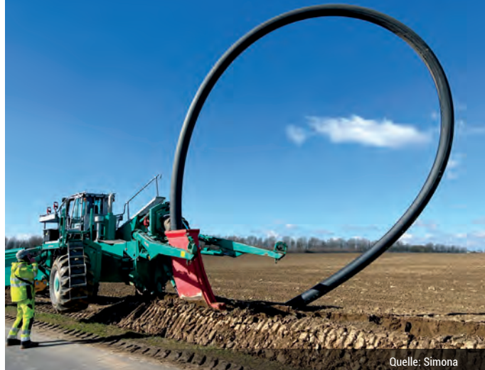
Wirtschaftliche Verlegung von Rohren mithilfe eines Pflugverfahrens – wie hier bei einer Trinkwasserleitung aus Polyethylen.
