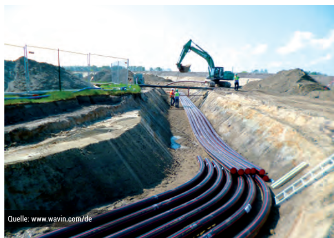
Bau einer Höchstspannungsstromtrasse mit Schutzrohren aus Kunststoff.
