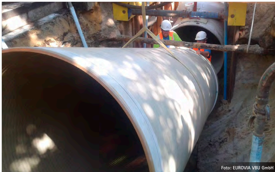
Bild 1: Einbringen des GFK-Rohres DN 1500, Baulänge 4,50 m, in den Rohrgraben.
