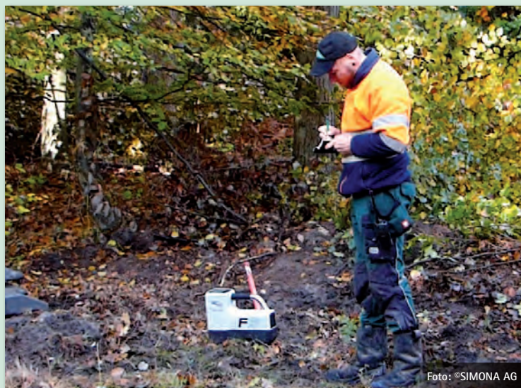
Bild 8: Ein spezielles Ortungssystem diente den Projektbeteiligten zur Lokalisierung und Steuerung der Pilotbohrung.
