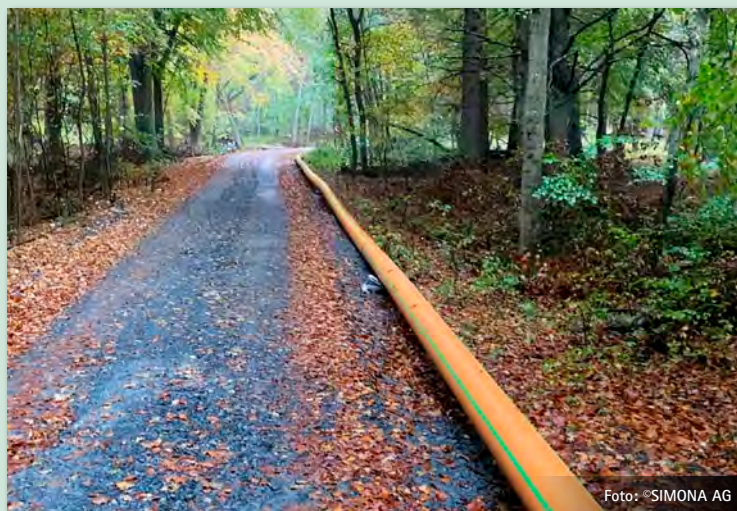
Bild 10: Die PE 100 SPC-RC-Line Schutzmantelrohre von SIMONA bieten einen hohen Schutz vor mechanischen Beschädigungen – wie Kerben, Abrieb und Verschleiß. Zudem weisen sie eine hohe Spannungsrissbeständigkeit auf.
