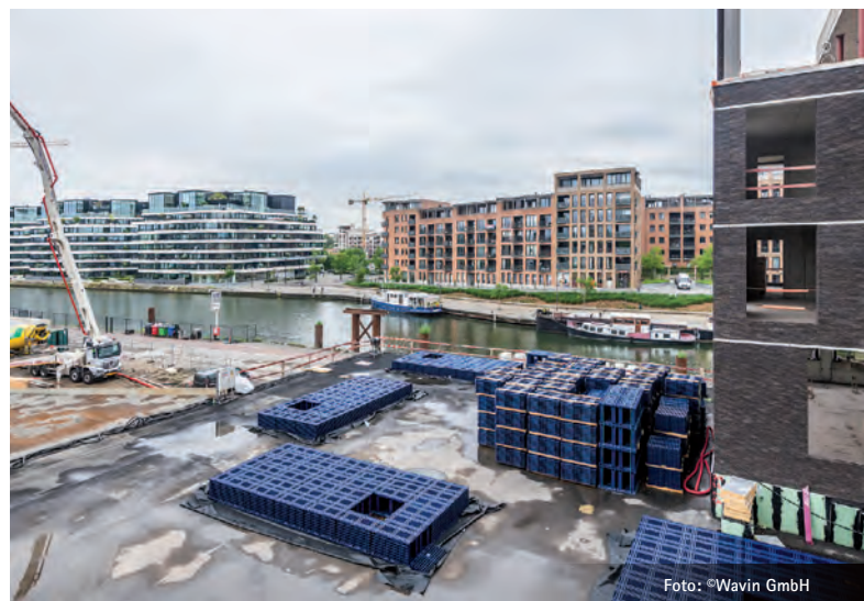
Bild 3: Für einen nachhaltigen Baumwuchs und ein verbessertes urbanes Mikroklima – der Einbau des auf dem modularen Versickerungs- und Rückhaltesystem Wavin Q-Bic Plus basierenden TreeTanks ist eine langfristige Investition in eine grüne und lebenswerte Stadt von heute und morgen.
