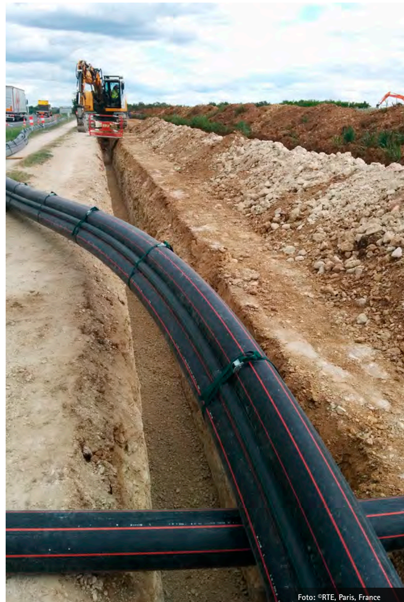
Bild 4: Kabelschutzrohrinstallation im offenen Graben
