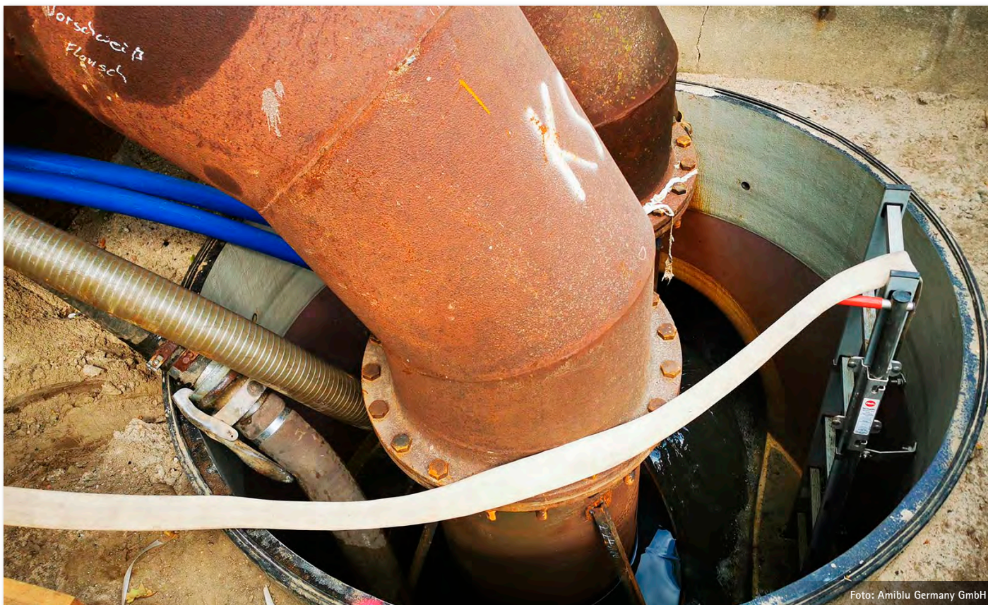
Bild 3: Der Auslauf der Abwasserumleitung Stahl DN 600 in den GFK-Schacht DN 2000.
