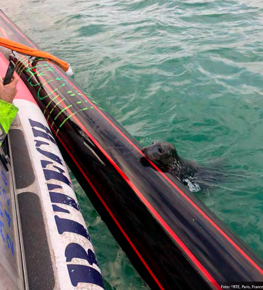
Bild 2: Begutachtung des IFA2 PE100-HT Rohrs vor HDD-Installation
