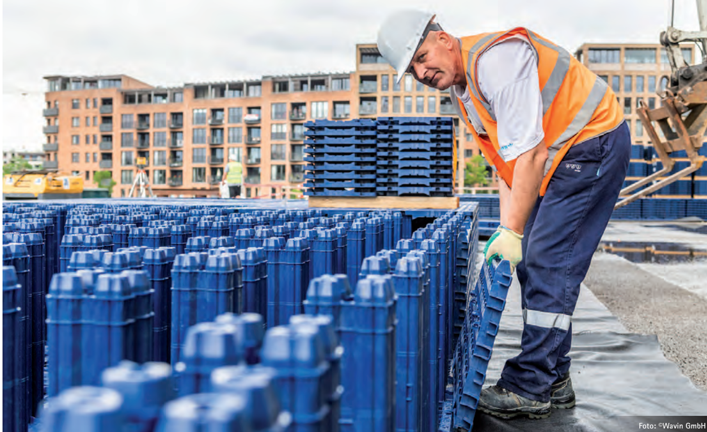
Bild 4: Bedingt durch den modularen Aufbau des Versickerungs- und Rückhaltesystems Wavin Q-Bic Plus, kann der Wavin TreeTank auf nahezu jede individuelle Einbauanforderung abgestimmt werden.
