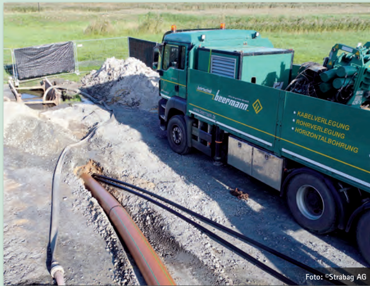
Bild 3: Die beim grabenlosen HDD-Verfahren eingesetzten Druckrohre lieferte die SIMONA AG.
