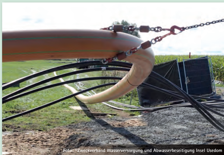
Bild 9: Dank des flexiblen Rohrmaterials ging der Einzug des Rohrstrangs problemlos und zügig vonstatten.
