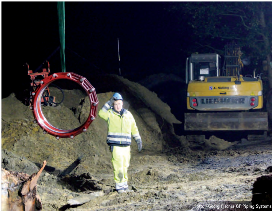
Bild 2: Safety first – sicherer und zentrierter Transport der MULTI/JOINT® 3000 Plus Kupplung.
