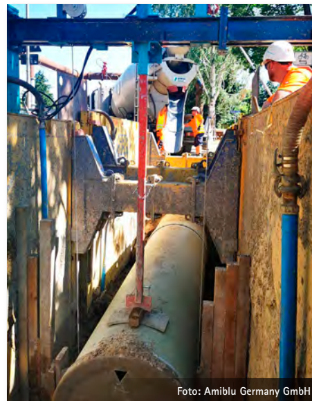
Bild 2: GFK-Rohr DN 1200, eingespannt in der Verlegehilfe kurz vor Einbringung des Flüssigbodens.
