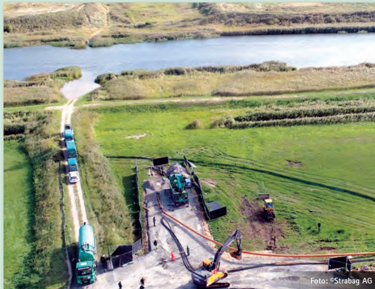
Bild 2: Eine Besonderheit im Rahmen der Baumaßnahme bestand in der Unterquerung des Küstenflusses Peene. Der Düker wurde als Einzelbohrung über eine Länge von rund 800 Metern realisiert.
