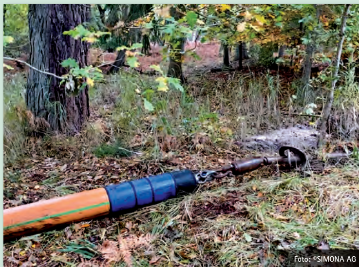
Bild 7: Nach erfolgter Bohrung und Reinigung wurden die SIMONA® PE 100 SPC-RC-Line Druckrohre nach und nach in das Bohrloch eingezogen.
