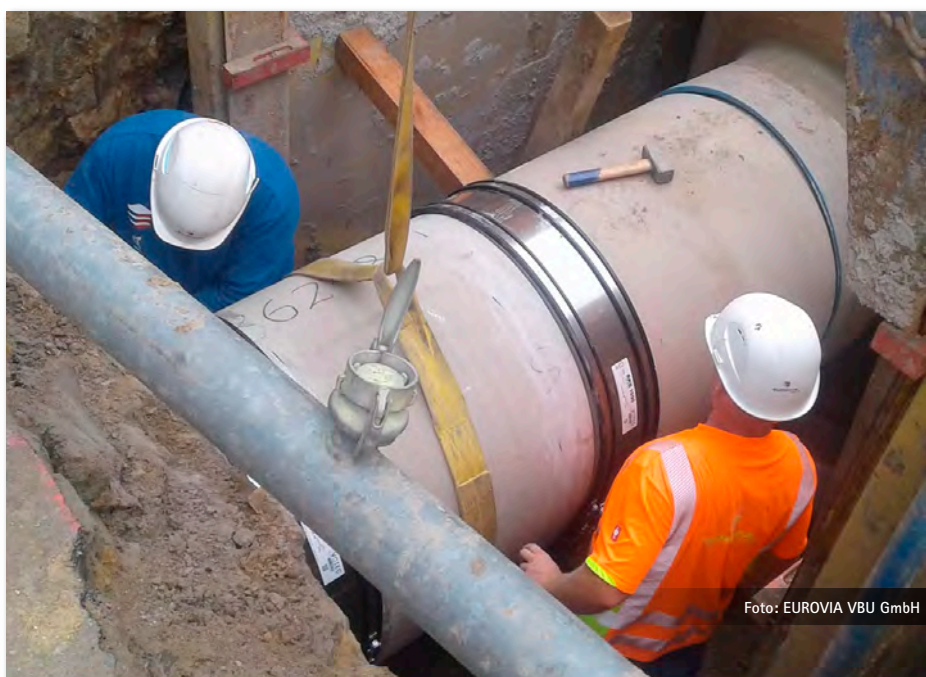
Bild 4: Einbau eines Passstücks zwischen vorhandenem Kanal GFK-Eiprofil 800/1200 und Gelenkstück.
