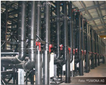
Entsalzungsanlage mit Rohren und Formteilen aus PE100
