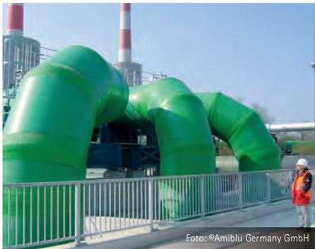
Kühlwasserleitung aus GFK in einem Gaskraftwerk
