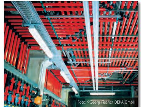
Einsatz von lebensmittelzugelassenen PVC-Rohrsystemen in der Essig- und Konservenindustrie (hier: 25 % Essigsäure (Eisessig) bei  $T = 15\text{ °C}$ )
