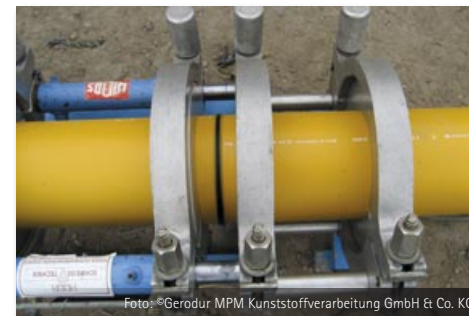
Bild 27: Heizelement-Stumpfschweißen
