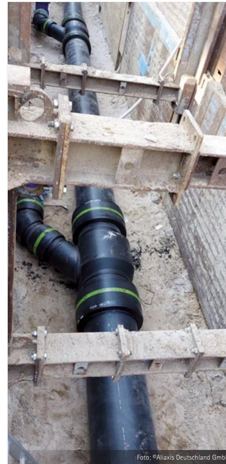
Bild 34: Einbau im Graben mit Sandbett
