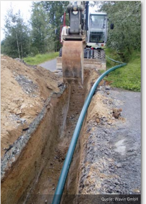
Einbau eines PE 100 RC-Druckrohres im offenen Graben
